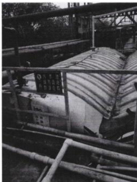
低浓度废水收集池
