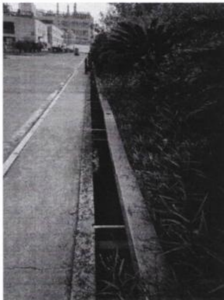
雨水收集明沟
